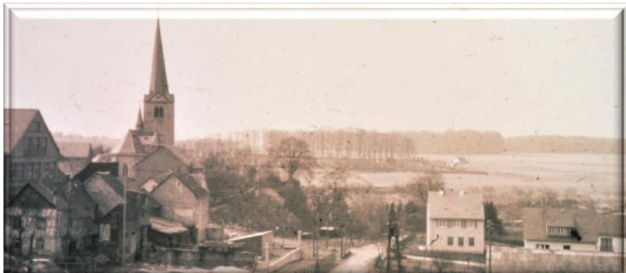
Friedr.-Back-Str. (frühe 60er): Im Vordergrund(li) ist der Wallgraben bereits teilweise überbaut. Der Neubau (re) liegt an der neuen Straße.
