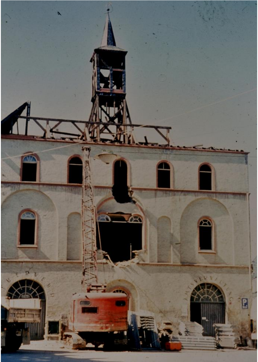
Abriss des Rathauses
